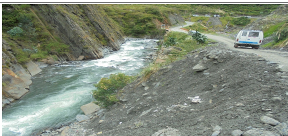
IMAGEN 02: SE MUESTRA EL ESTADO ACTUAL DEL CAUCE DEL RIO CHULLO QUE REQUIERE DE PROTECCION EN AMBAS MARGENES PARA EVITAR LA EROSION Y MITIGAR INUNDACIONES
